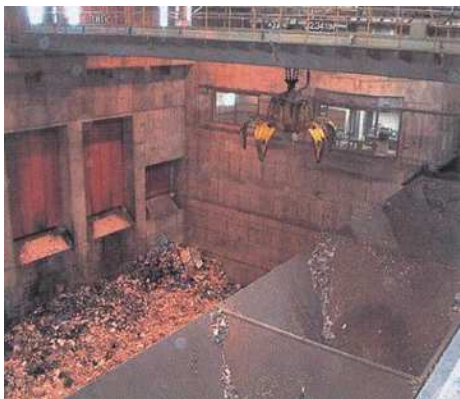
ごみピットの様子
