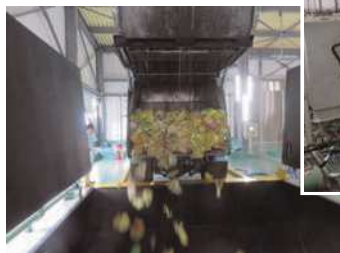
生ごみピット
